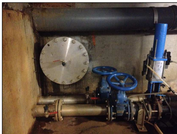
Réservation en place au niveau de la bache eaux sales pour raccordement des eaux issues du lavage d'une nouvelle unité de biofiltration
