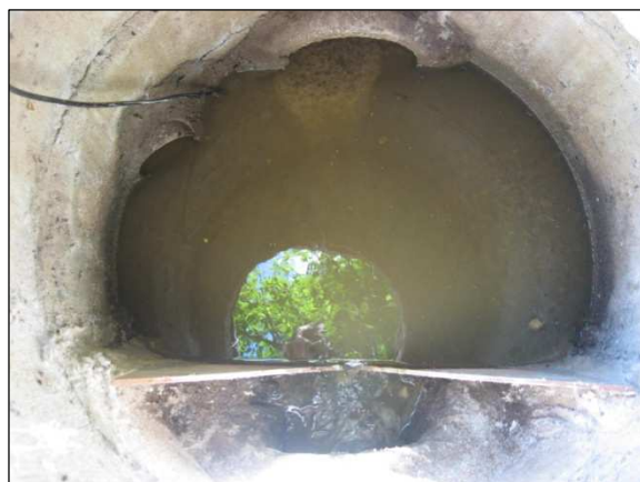
Photographie du point de mesures installé au réseau d'eaux usées de La Ribière
