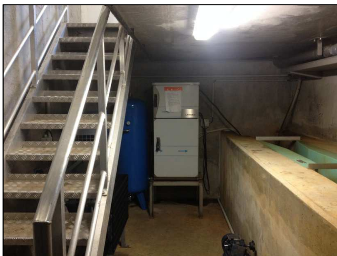
Ouverture à créer dans ce mur au niveau "-1" du bâtiment pour l'alimentation en air, l'alimentation en eaux usées et l'évacuation des eaux de lavage de la nouvelle unité de biofiltration, ainsi que pour l'accès à la nouvelle unité
