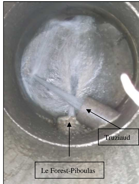
Eaux Claires Parasites Permanentes en provenance de l'antenne de Truziaud et en provenance de l'antenne de Forest-Piboulas (regard 0060342754)
