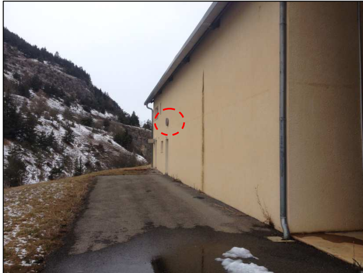
Réservation en place pour raccordement des eaux traitées d'une nouvelle unité de biofiltration à la bâche eaux traitées commune aux 3 unités existantes
